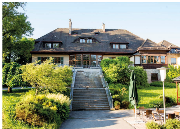
Foto: Klinik Hochried in Murnau
