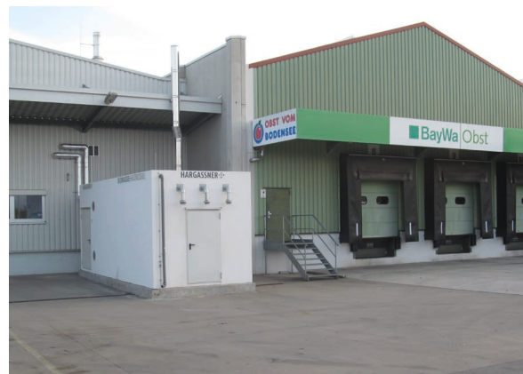
Foto: BayWa Energie Dienstleistungs GmbH
