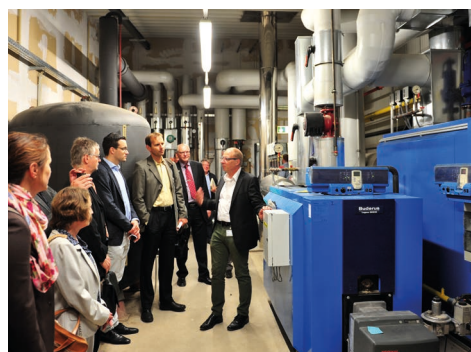
Besichtigung der Westfalenhallen Foto: EnergieAgentur.NRW / Klaus Voit
