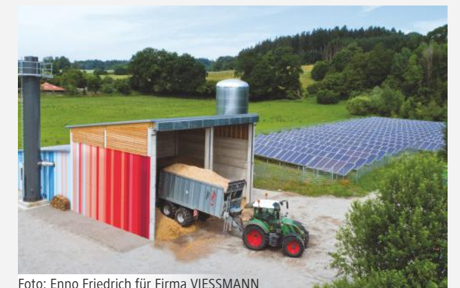
Foto: Enno Friedrich für Firma VIESSMANN
